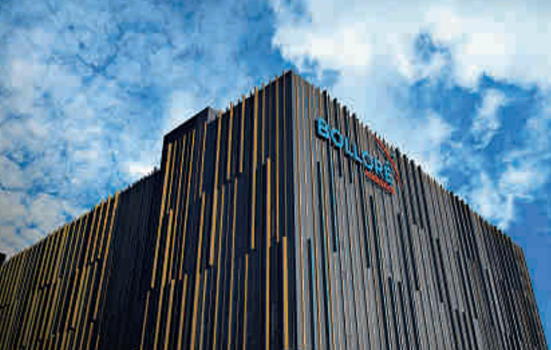
BlueHub de Singapour, le bâtiment ultramoderne dispose, entre autres, d'un système avancé de gestion de l'énergie s'appuyant sur l'Internet des objets. Green Mark Platinum (1) remporté en mai 2019.
