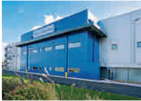
L'usine Blue Solutions de production de batteries LMP® à Quimper en Bretagne.
